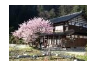
古民家等の改修
