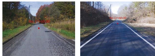
飯舘村農道工事 (左:施工前、右:竣工後)
