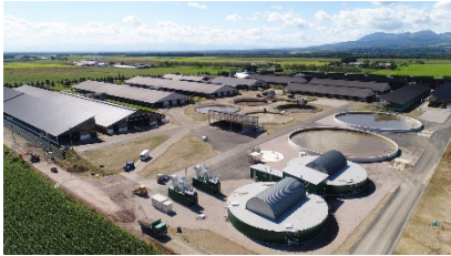
バイオガスプラント
