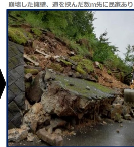
崩壊した擁壁、道を挟んだ数m先に民家あり
