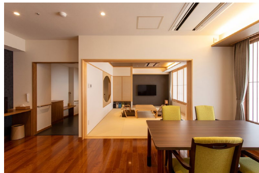
客室の手すり整備、段差解消
