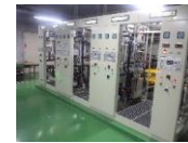
修繕・更新工事
