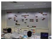
流量・水圧等の監視 (24時間・365日)
