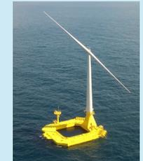
低コスト浮体式洋上風力発電システム実証機
