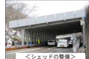
<シェットの整備>
