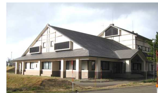
柿崎浄化センター
