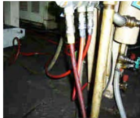
エアリークが漏れていないか
