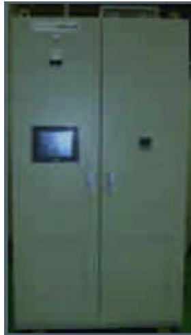
ポンプ類をインバーター制御しているか
