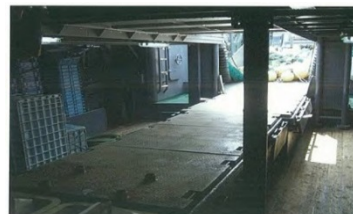
固定オーニング (上部覆い)設 置により、荒天 時作業の安全 性を確保
