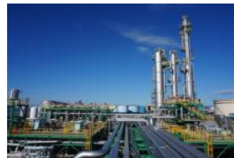
＜CO 2 分離・回収設備の建設＞
