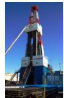
＜井戸の掘削装置＞
