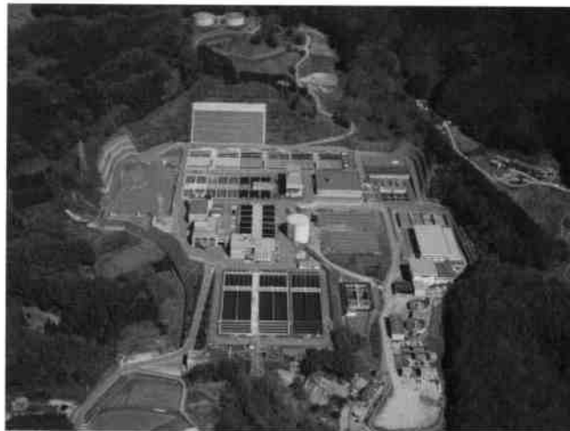
御所浄水場（奈良県・水道事業） 水道水をつくるための電力等、水道事業について省エネルギー化を図るため、太陽光発電施設を導入し、地球温暖化対策に積極的に取り組んでいます。
