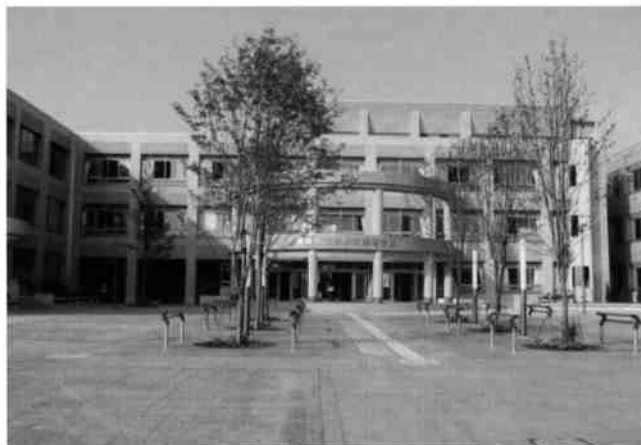
県立青森東高等学校（青森県・臨時高等学校整備事業） 老朽化した校舎を改築したことにより、利用者である生徒の利便性や満足度が向上し、さらには教員等の職場環境の改善が図られています。
