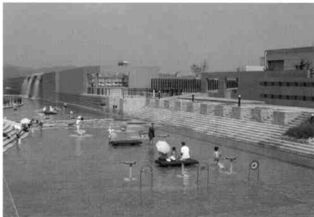
アクアパークモデル事業（山口県下関市・下水道事業） 下水道資源を積極的に活用・整備した親水池や人口滝等は、市民の憩いの場として親しまれ、多くの市民に下水道のアピールとイメージアップが図れる場となっています。
