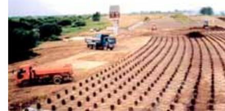
パイルネット工法による軟弱地盤上の堤防建設
