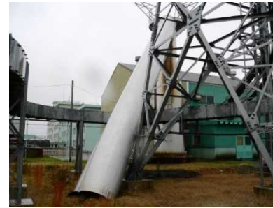
↑ 老朽化が進み、倒壊したボイラー煙突。
