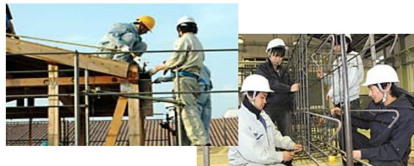
建築施工実習
