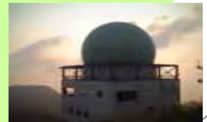
航空路監視レーダー
