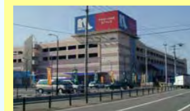
福岡市(ホームセンター)
