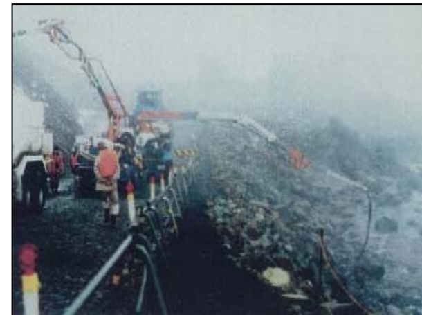
コンクリートポンプ車を使用した漂着油の回収
