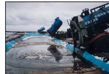
仮設ピットに集積された回収油
