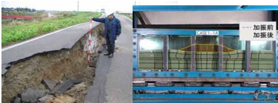
中越地震時の堤防被害
