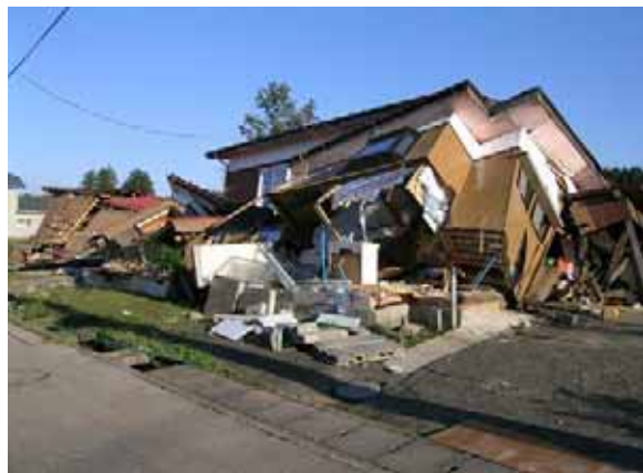
平成16年新潟県 中越地震被害調査
