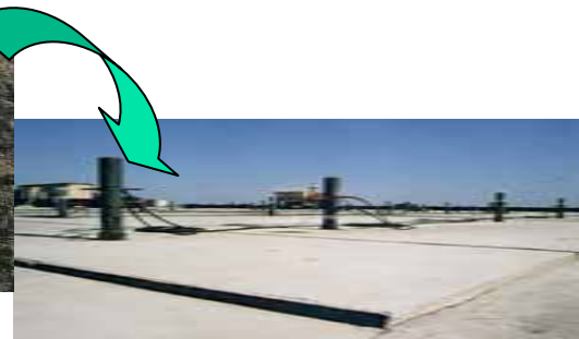
沈下に対応する新構造駐機場
