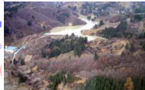
河道閉塞現場
