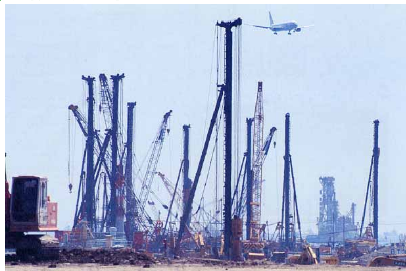
地盤改良状況写真
