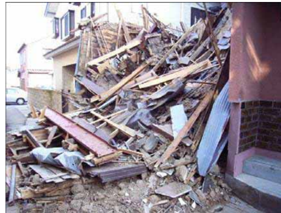
平成19年能登半島 地震被害調査
