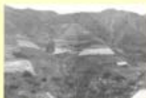
久慈河右岸の昭和30年代の状況
