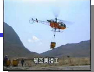
航空実播工実施状況(監督・確認)
